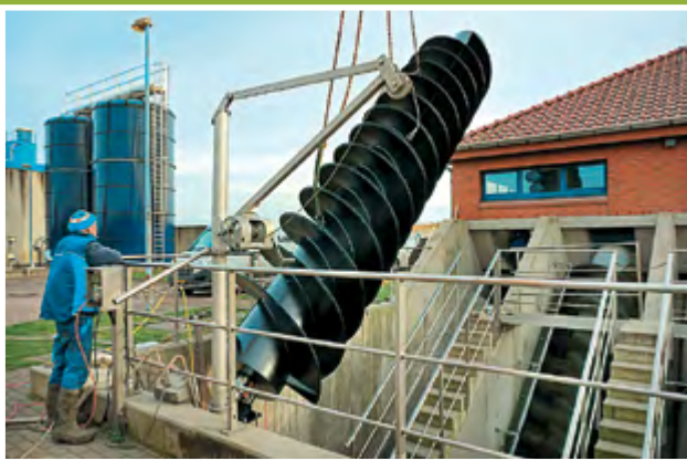
VkWA Salzwedel: Erneuerung des Zulaufbauwerks.
